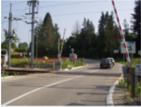
Figure 1 : passage à niveau muni d'une SAL avec barrière
