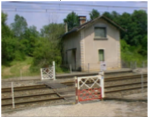
Figure 5 : passage à niveau piéton avec portillon
