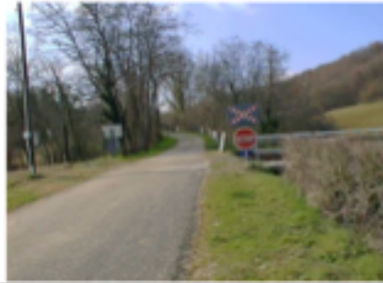
Figure 3 : passage à niveau avec croix de Saint André, un STOP et sans barrière
