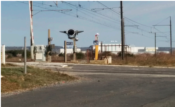
Passage à niveau 413 à Rivesaltes (66) avec trois feux rouges sur le même support, deux pour la route principale et tourné vers une petite route adjacente
