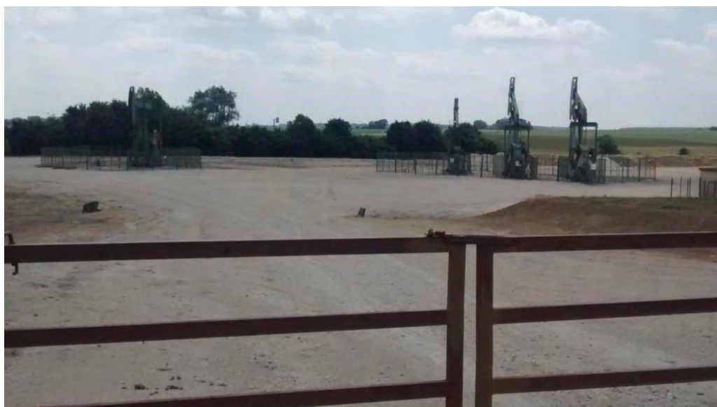
Figure 2 : plateforme d'exploitation d'hydro- carbures conventionnels à proximité de Vaudoy-en- Brie, sur la concession de Champotran
