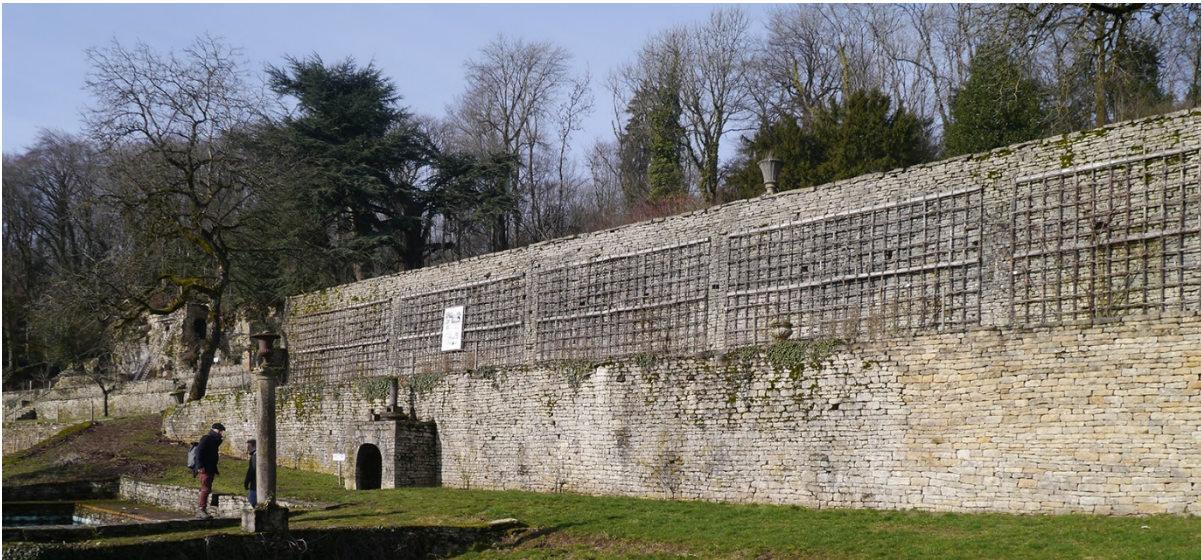
Mur de soutènement du jardin des terrasses – Ph. B. Hervier
