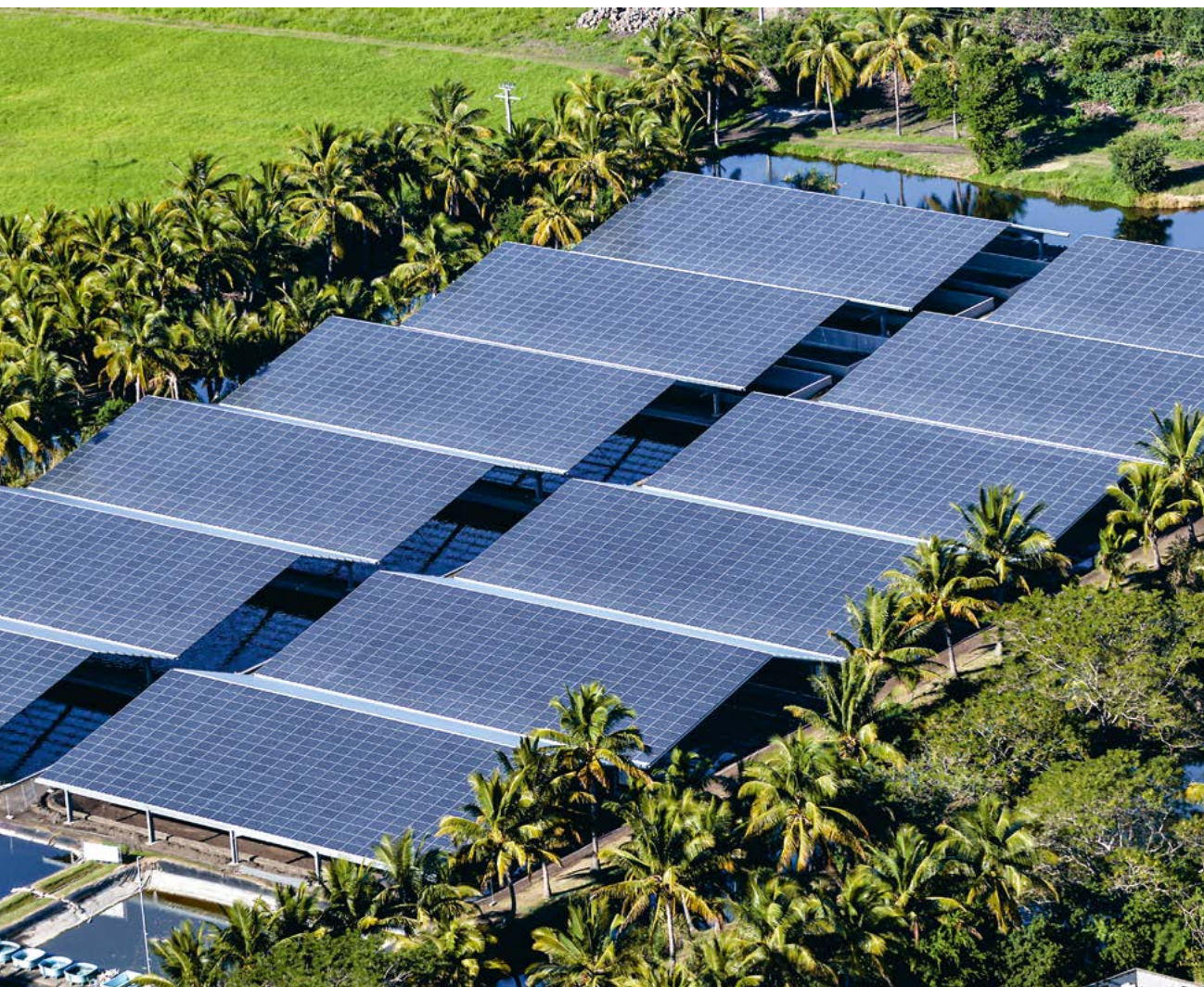
Parc photovoltaïque de L'Étang-Salé à la Réunion © CRE
