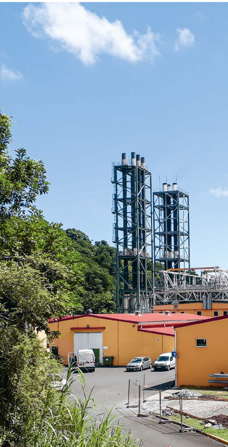
Centrale électrique de Longoni à Mayotte. © CRE
