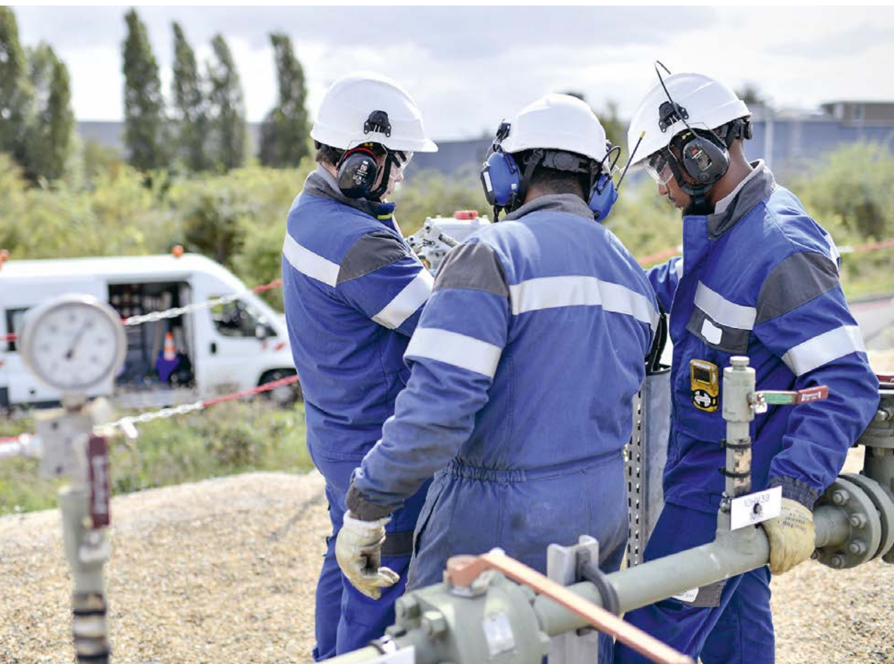
Maintenance sur la station d'interconnexion. © GRTgaz/Dunouau Franck
