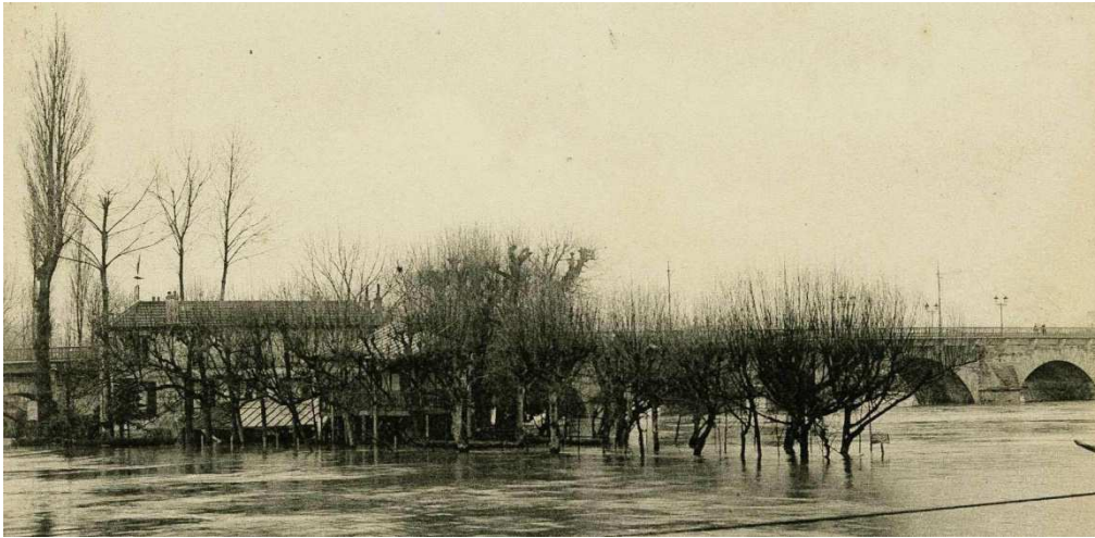
Extrait carte postale ancienne - Joinville-le-Pont, inondations de la Marne 1910 - Pointe de l'île Fanac Restaurant de l'Ermitage - 2FI / Joinville 123 - Archives départementales du Val-de-Marne
