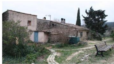
48 - Ferme sur les contreforts
