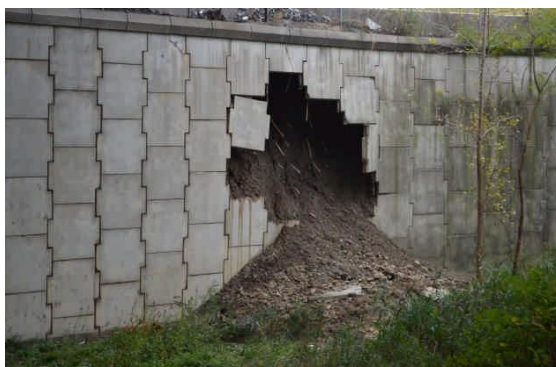
Figure 10.: photos de l'incident survenu en octobre 2016- bretelle du Saw Mill River. Parkway (Etat de New York) et photo de la réparation au moyen d'un clouage
