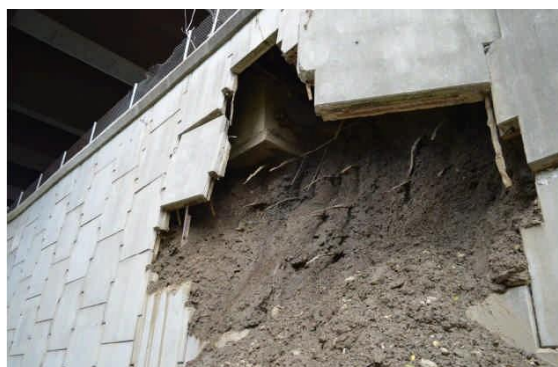
Figure 10.: photos de l'incident survenu en octobre 2016- bretelle du Saw Mill River. Parkway (Etat de New York) et photo de la réparation au moyen d'un clouage
