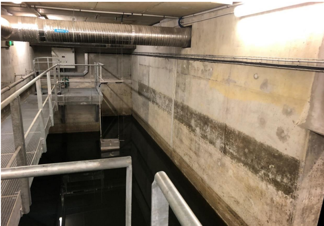
Figure 6 Bassin de rétention (photo mission)
