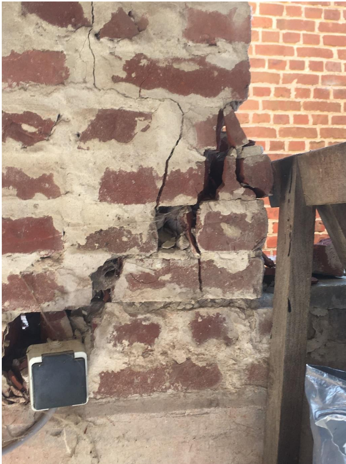
Photo n° 2 : sinistre non indemnisé – Commune de Lederzeele (59) reconnue catastrophe naturelle
