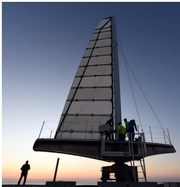
photo 8: Crédit photos : Antoine Pichon/CGEDD
